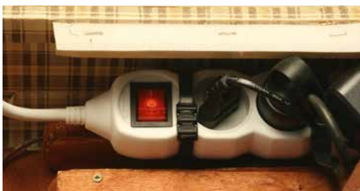
3 - Appuyer sur l'interrupteur électrique rouge (multiprise) situé dans la ciné-valise. Il met sous tension le lecteur DVD, le vidéoprojecteur et l'enceinte.
