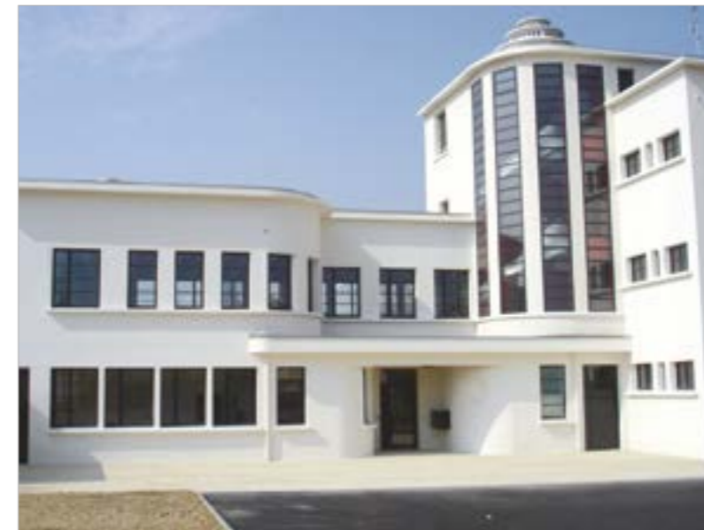
LE PIAF, SITE DU PÔLE PATRIMOINE, À ISSOUDUN.
